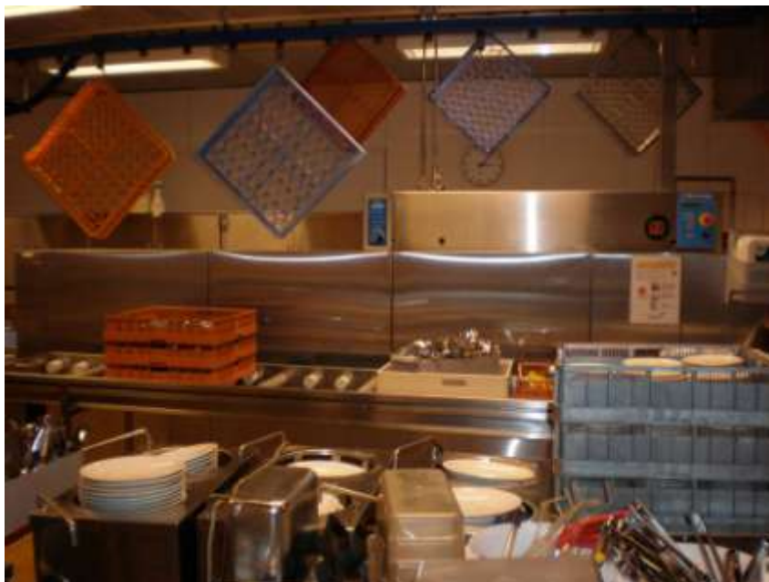
Inmatning till tunneldiskmaskin.
